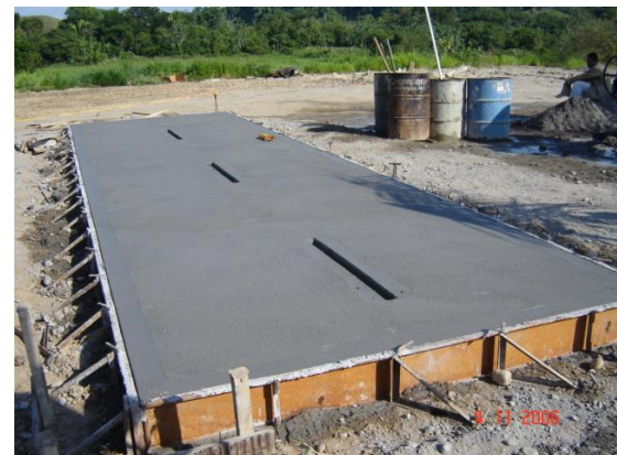
Losas para unidades de Bombeo Mecánico Campo Jazmín – MANSAROVAR ENERGY COLOMBIA LTD.
