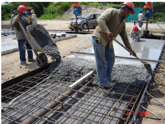
Losas para unidades de Bombeo Mecánico Campo Jazmín – MANSAROVAR ENERGY COLOMBIA LTD.
